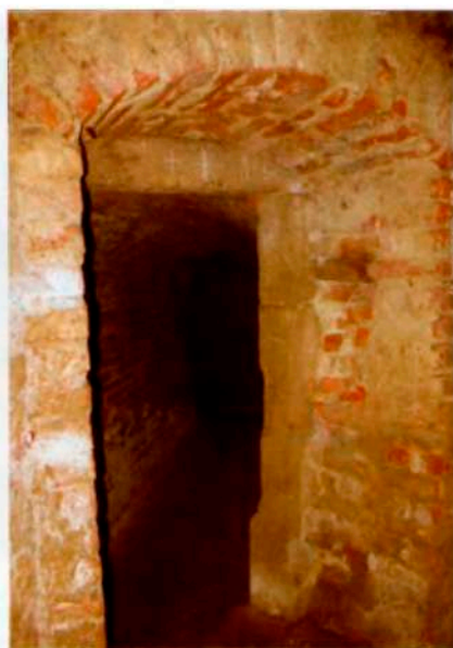
Дверной проем подземного хода. Несвиж Минской обл. 2001–2006 гг. Раскопки А.А. Метельского Door opening of the subterranean passage. Nesvizh, Minsk region. 2001–06. Excavations by A.A. Metelsky
