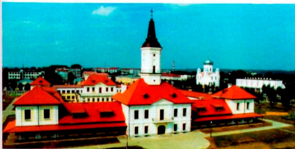
Ратуша с гостиним двором. После реставрации. XVIII в. Шклов Могилевской обл. Фото А.Н. Белясова Town hall and shopping arcades. After rebuilding. The 18th cent. Shklov. Mogeliv region. Photo by A.N. Belyasov
