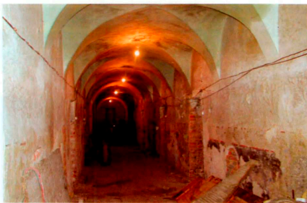
Коридор второго этажа южного крыла Иезуитского колледжума. Орша Витебской обл. 2008 г. Southern part of Jesuit Collegium. Gallery on the first floor. Orsha, Vitebsk region. 2008
